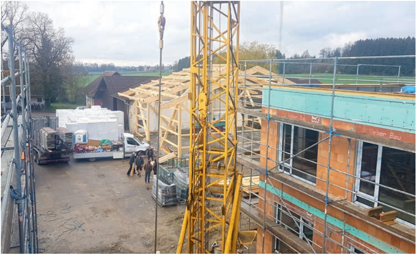
Auf dem Riesenhof bei Ravensburg entsteht ein Fachpflegeheim mit Wohnplätzen für Menschen mit Unterstützungsbedarf.
